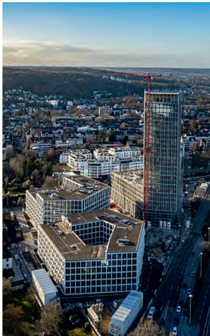
Mit 101,5 m Höhe ist die Landmarke des Neuen Kanzlerplatzes weithin über den Dächern Bonns sichtbar.
