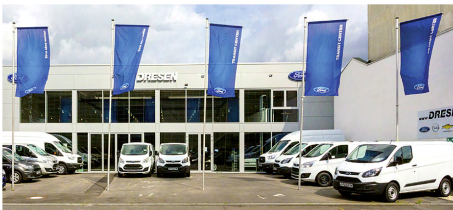
Das Bonner Nutzfahrzeug Center der Dresen Gruppe auf der Vorgebirgsstraße
