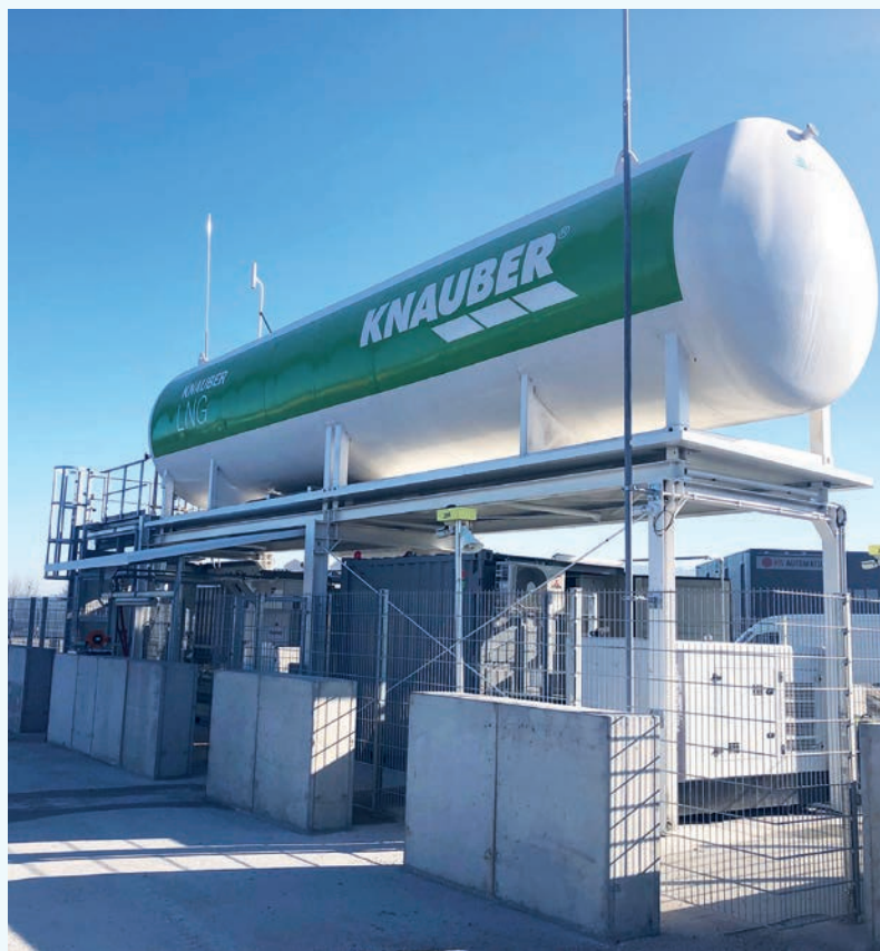
Die neue LNG-Tankstelle in Vöhringen nahe der A 81
