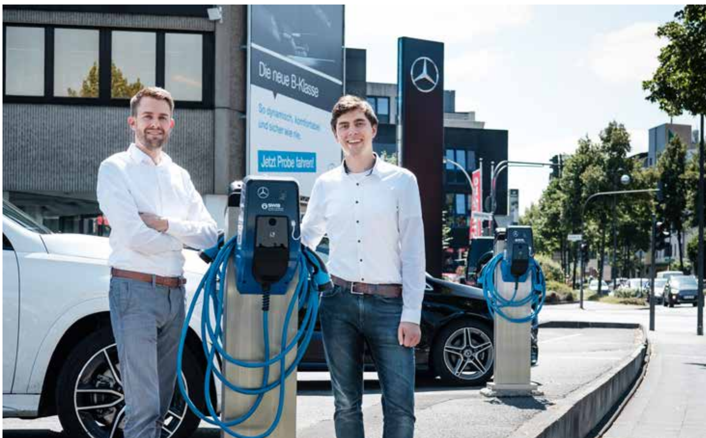
RGK hat gemeinsam mit SWB 8 Ladesäulen und 12 Wallboxen an ihren Standorten installiert. Die Fachbereichsleiter Elektromobilität Christopher Käckermann (li.) und Martin Nagel freuen sich über die Zusammenarbeit. (Foto: SWB/Martin Magunia)
