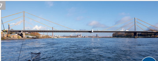
Rheinbrücke Neuenkamp (Baujahr 1970)
