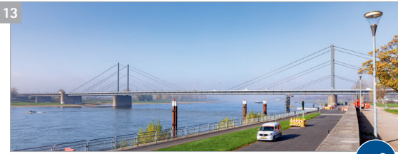
13 Theodor-Heuss-Brücke (Baujahr 1957) 3,0 1 Stadt Düsseldorf 2 Bundesstraße 7 3 72.500 Fahrzeuge, davon 3.000 Schwerlastverkehr 4 Ablastung von 30 Tonnen
