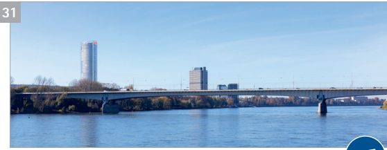
31 Konrad-Adenauer-Brücke (Baujahr 1972) 2.5 1 Bund 2 Autobahn 562 3 62.361 Fahrzeuge, davon 1.185 Schwerlastverkehr 4 keine
