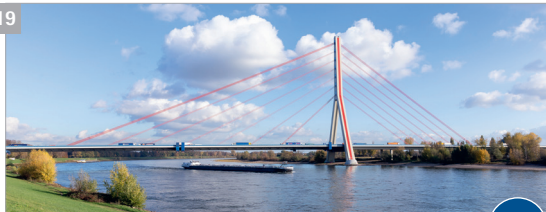
Fleher Brücke (Baujahr 1979)
