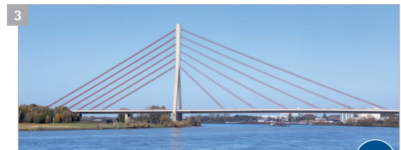
3 Niederrheinbrücke Wesel (Baujahr 2009)
