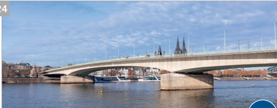
Deutzer Brücke (Baujahr 1948)
