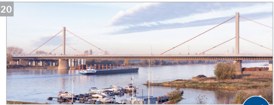
Rheinbrücke Leverkusen (Baujahr 1965)
