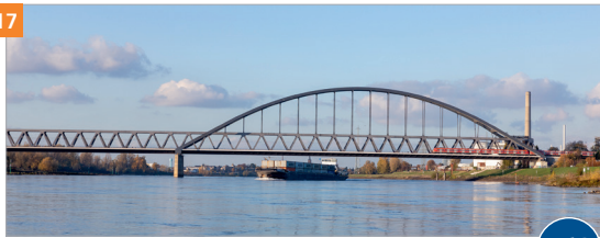
Hammer Eisenbahnbrücke (Baujahr 1987)
