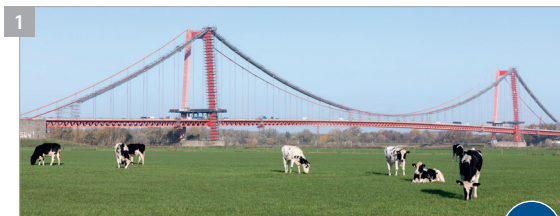
1 Rheinbrücke Emmerich (Baujahr 1963)
