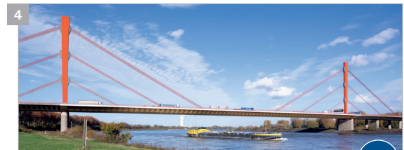
4 Beckerwerther Brücke (Baujahr 1990)
