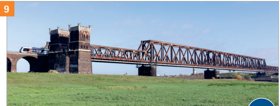
Duisburg-Hochfelder Eisenbahnbrücke (Baujahr 1949)
