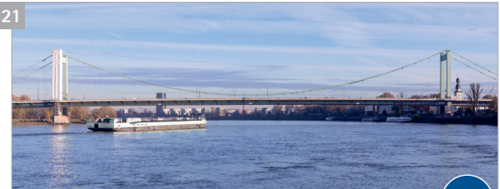
Mülheimer Brücke (Baujahr 1951)
