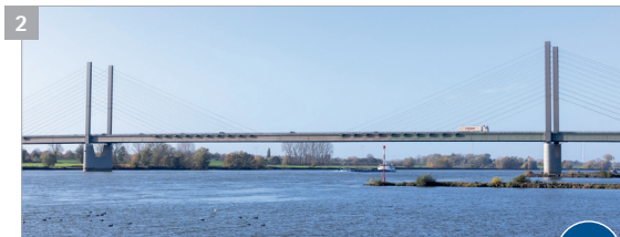
2 Rheinbrücke Rees-Kalkar (Baujahr 1967)
