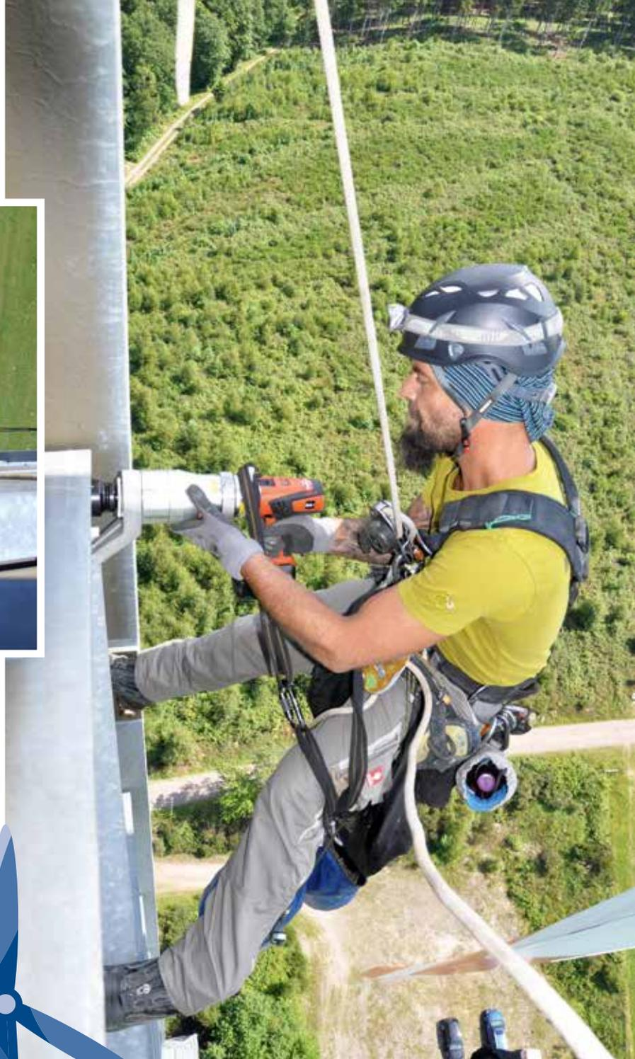
das Mucher Unternehmen unter dem Markennamen „PLARAD“, eine vom Firmengründer Paul-Heinz Wagner eingeführte Abkürzung des Wortes „Planetenradgetriebe“. Diese spezielle Art eines Zahnradgetriebes hat Wagner nicht erfunden, sich aber für die ersten von ihm entwickelten Verschraubungsgeräte zunutze gemacht. Die spezielle Anordnung der Zahnräder ermöglicht große Übersetzungsstufen und enorme Drehmomente, da die einzelnen Elemente die Leistung teilen und übertragen. Die Kraft wird vervielfältigt.
