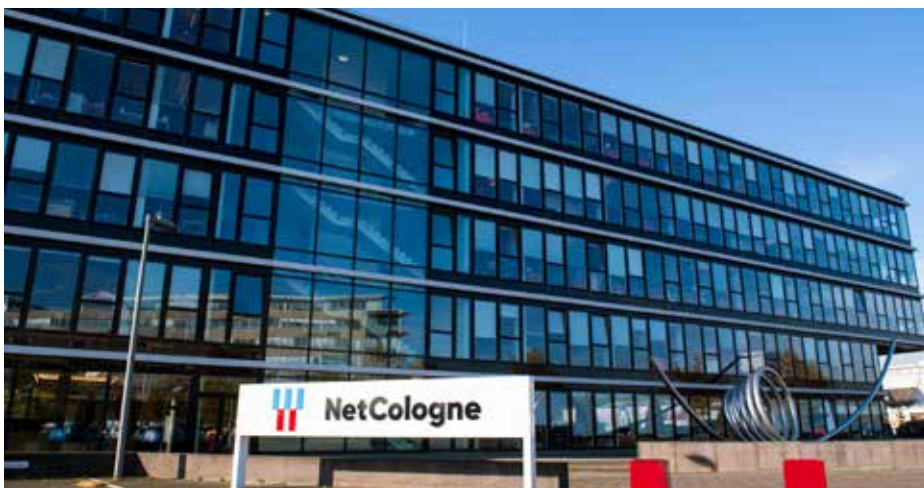
Rund 900 Mitarbeiter arbeiten in der NetCologne Zentrale in Köln-Ossendorf für höchste Sicherheitsstandards
