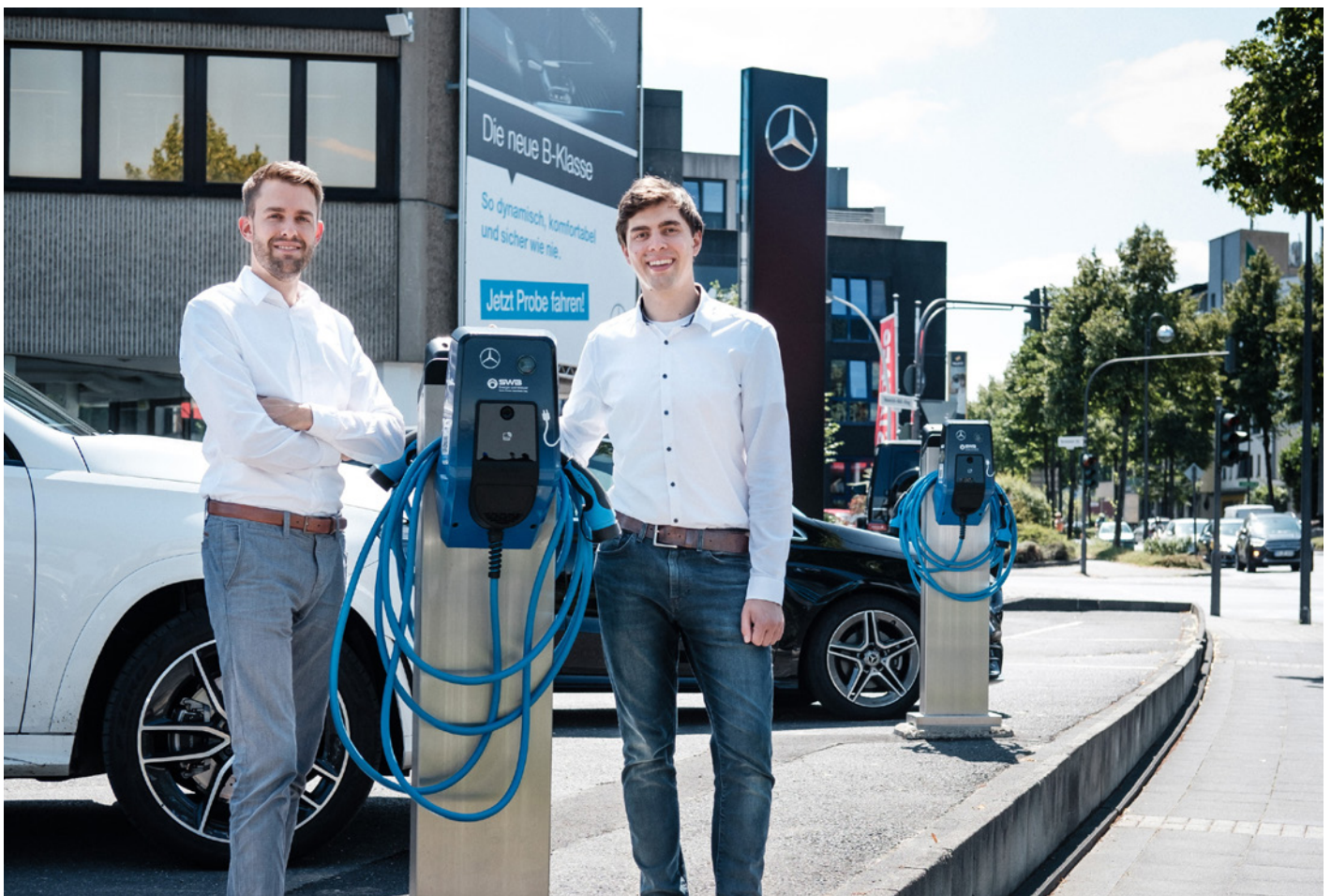
RGK hat gemeinsam mit SWB bisher 9 Ladesäulen und 12 Wallboxen an ihren Standorten installiert. Die Fachbereichsleiter Elektromobilität Christopher Käckermann (li.) und Martin Nagel freuen sich über die Zusammenarbeit. (Foto: SWB/Martin Magunia)
